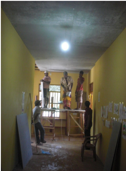
Deckeninnenverkleidung im Hauptgebäude im ersten Stock!
