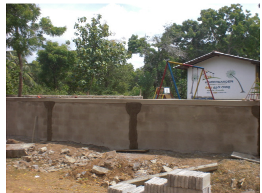
Mauer wird derzeit am Eliya Kindergarten gebaut!
