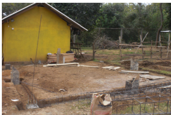
Hier entsteht das neue Wasserspeicherhaus
